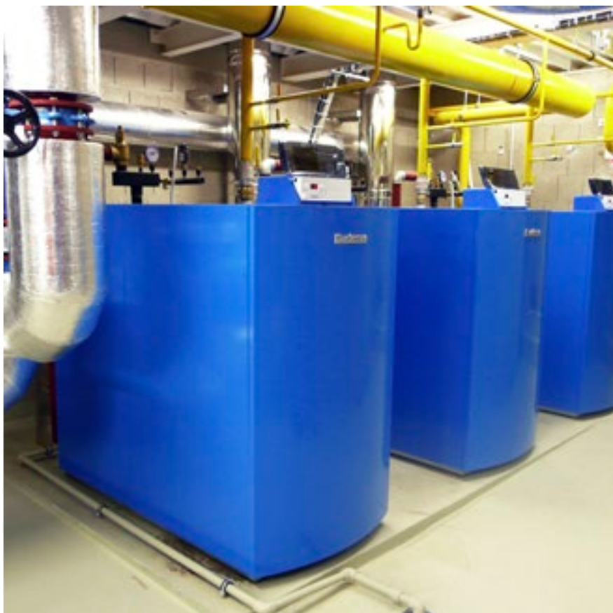
Corso Court Karlín Kaskáda stacionárních kondenzačních kotlů 3× Logano plus GB402 – 620 kW
